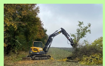
Bei der Heckenpflege im Einsatz: Bagger mit Zwickzange (Foto: Dr. F. Müller-Waldeck)
